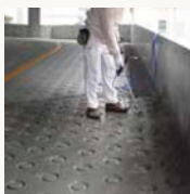
立体駐車場スロープ
